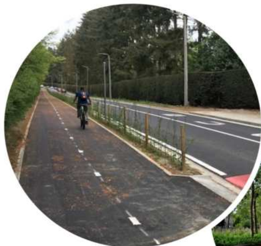
CYCLOSTRADE (EN CHEMIN RÉSERVÉ)
