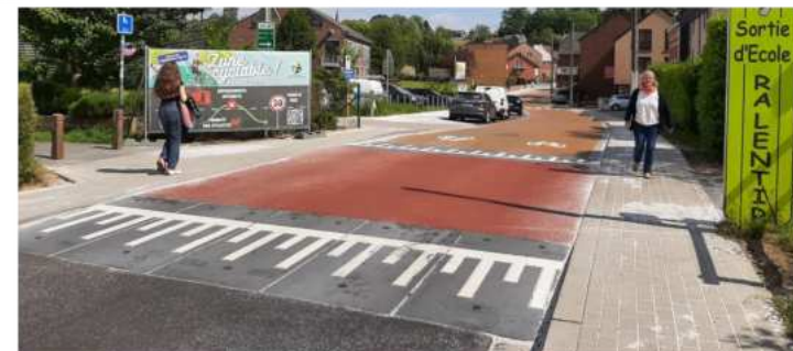
Plateau surélevé schlamé pour marquer l'entrée de zone. Source : Pluris, 2023
