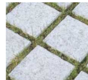
Pavés à joints ouverts. Source : Pluris, 2024
