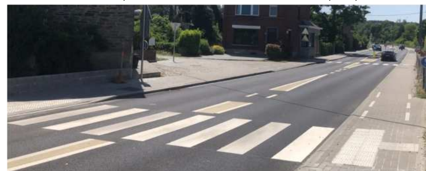
Ilôt séparateur franchissable - Rue du Marais (N275) © Pluris, 2023
