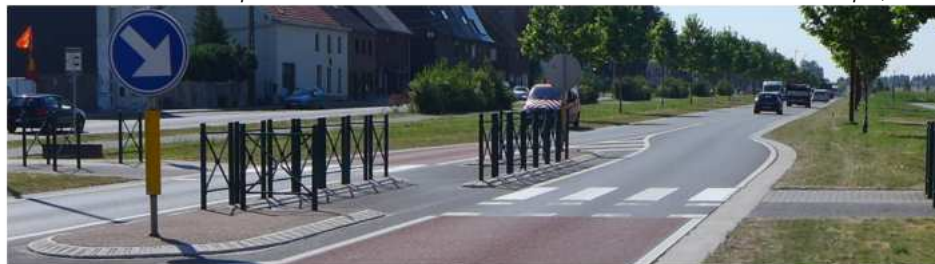
Dévoisement avec îlot central non franchissable pour traversée piétonne. Fiche n° 177 Sécurothèque, 2020
