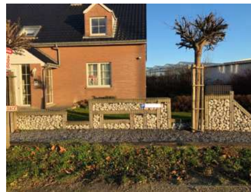
Exemple à éviter : gabions. Source : Pluris, 2024
